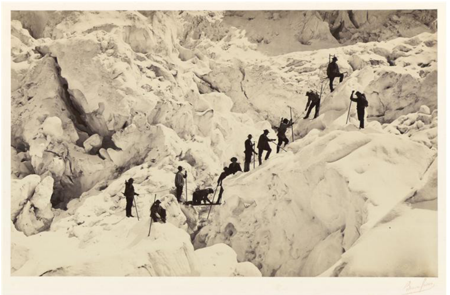
Frères Bisson, Savoie - passage à l'échelle horizontale , 1862. Collection Musée Cantini, Marseille. © Ville de Marseille, Dist. RMN-Grand Palais / image des musées de la ville de Marseille.
